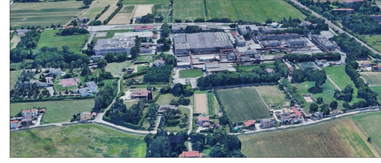
DOCUMENTAZIONE FOTOGRAFICA FASCIA BOSCATI ESISTENTE
