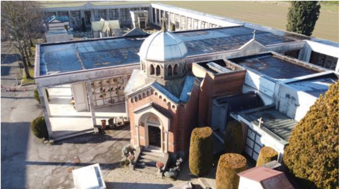
Vista aerea interna
