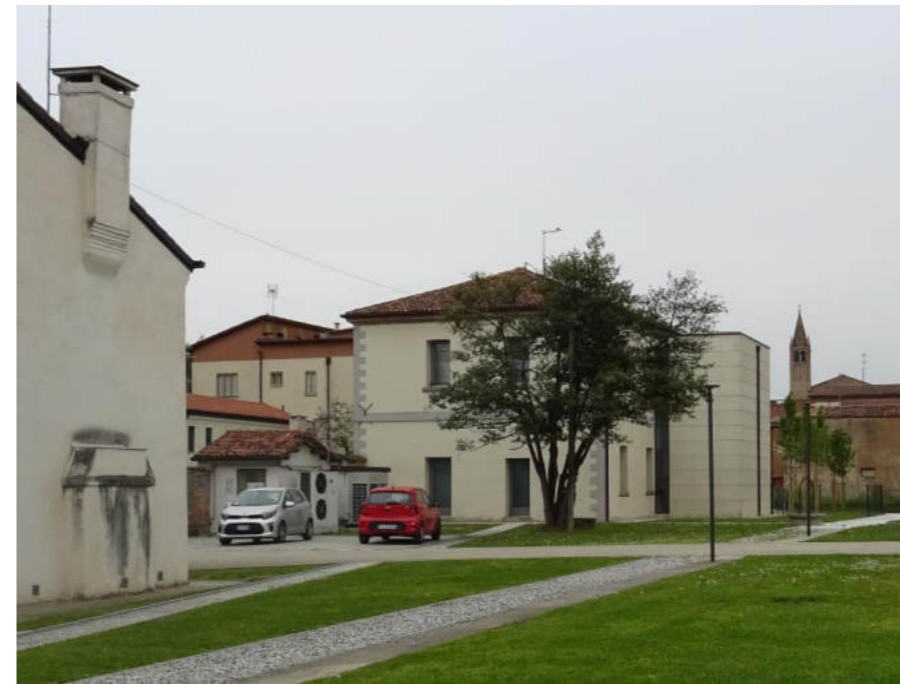
Foto n. 51 – Edifici n. 32 e 33
