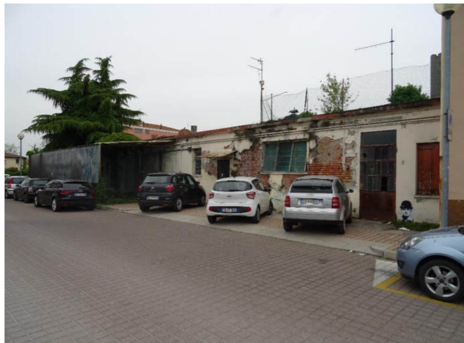
Foto n. 46 – Edificio n. 66.a
