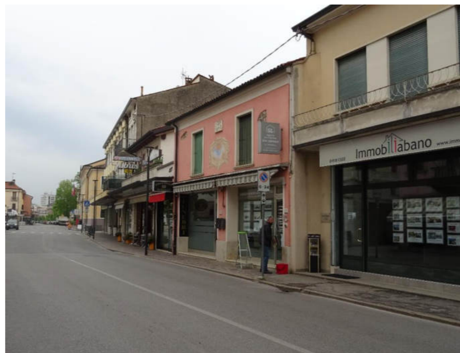
Foto n. 4 - Edificio n. 27.a
