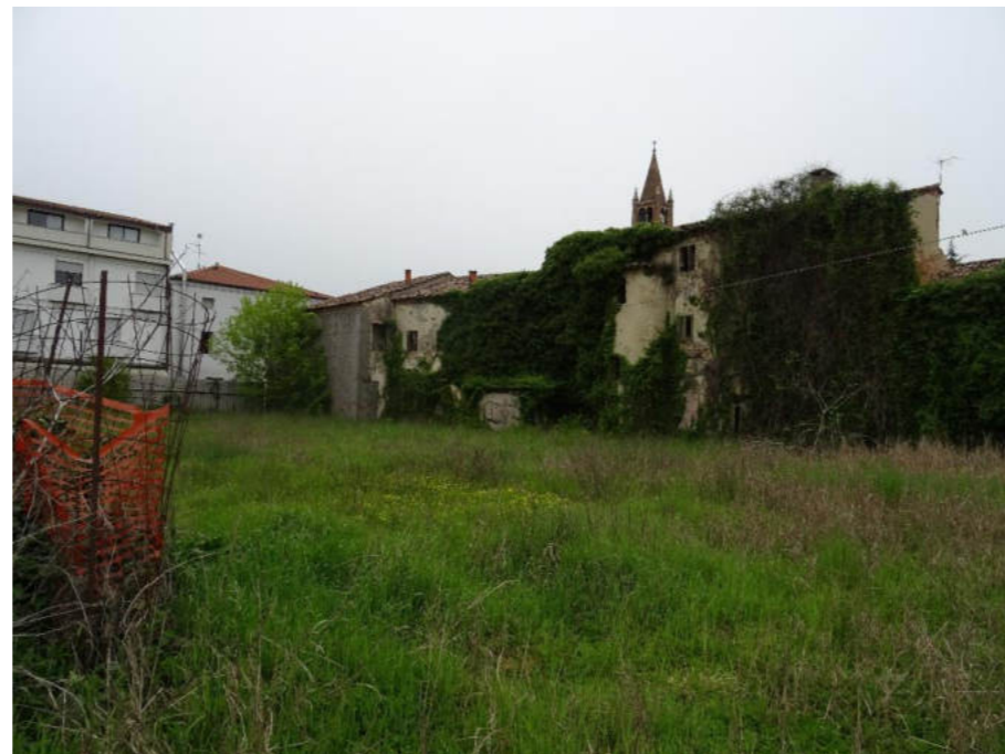
Foto n. 65 – Lotto n. 12 sud
