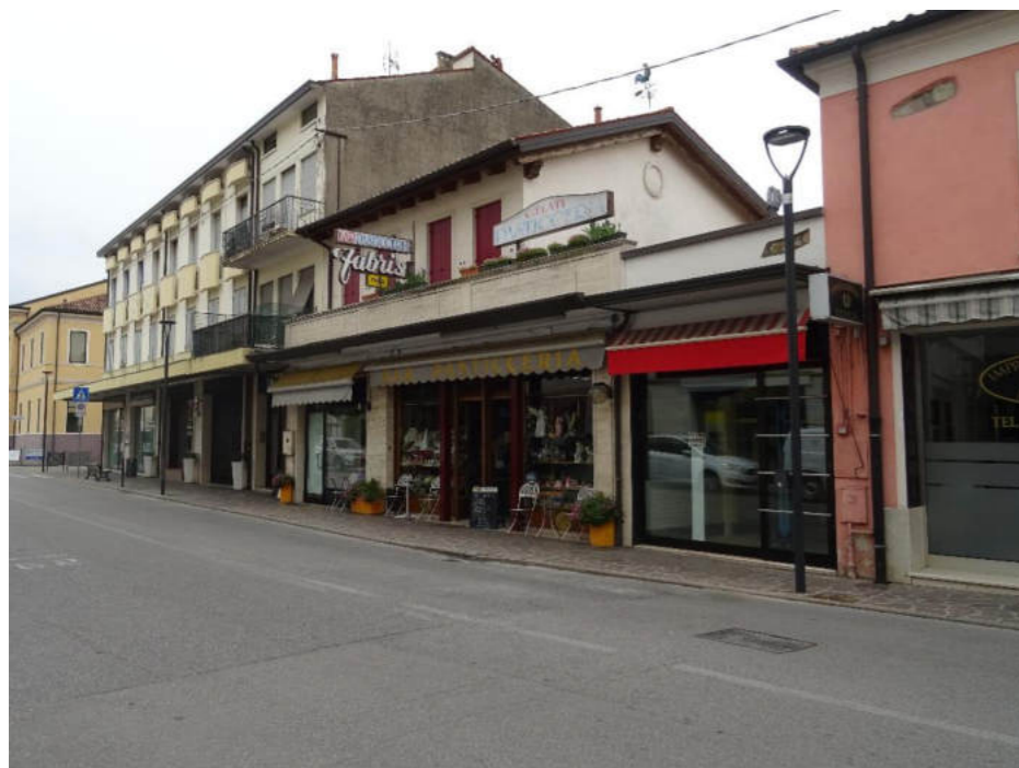
Foto n. 3 - Edificio n. 27.b
