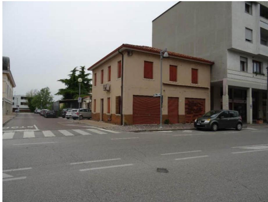
Foto n. 29 - Edificio n. 66.b
