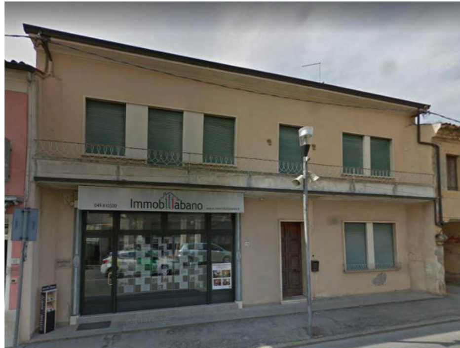
Foto n. 5 – Edificio n. 27.c
