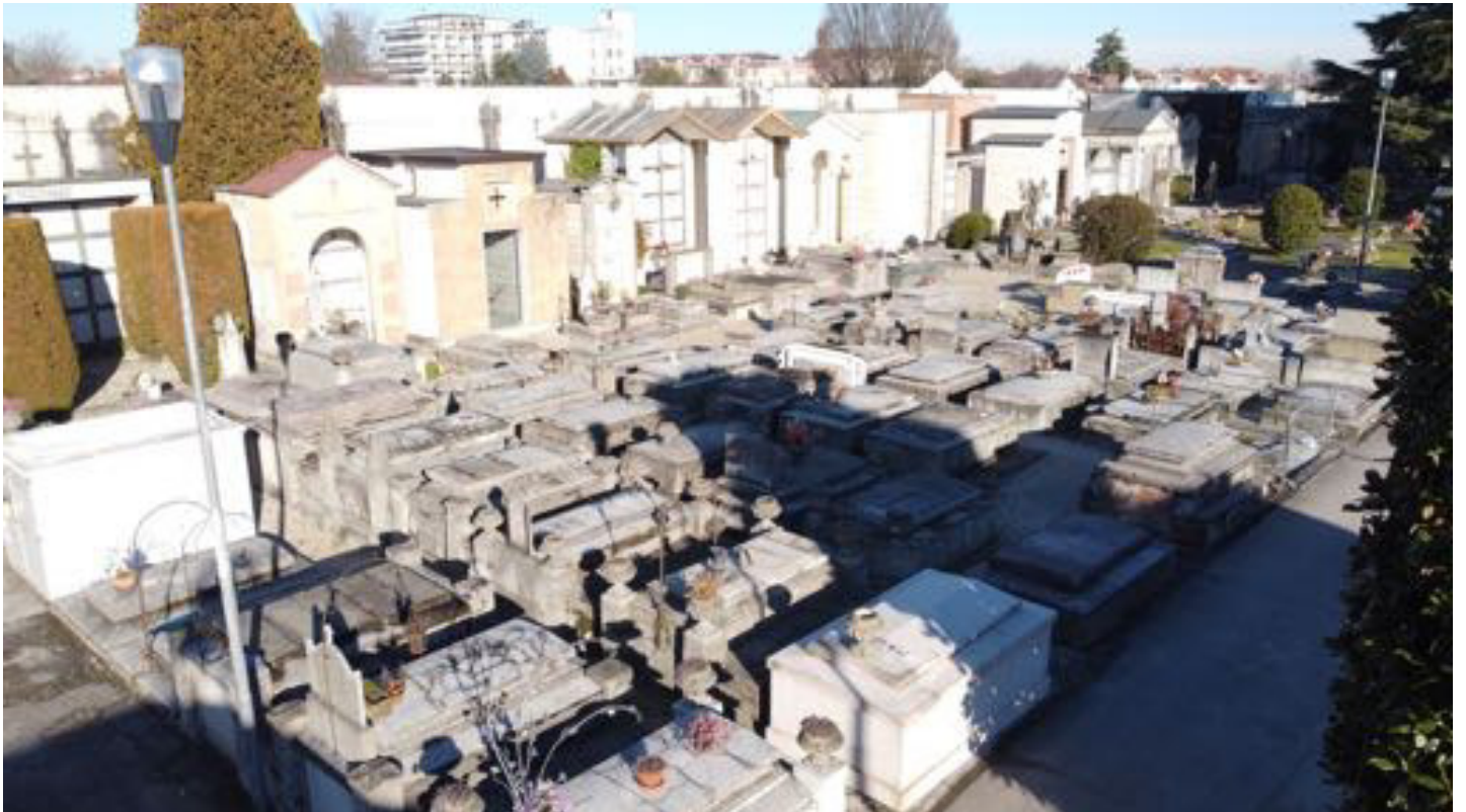
Vista interna tombe "storiche"
