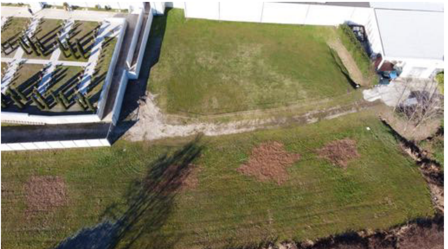
Vista aerea zona futuro ampliamento
