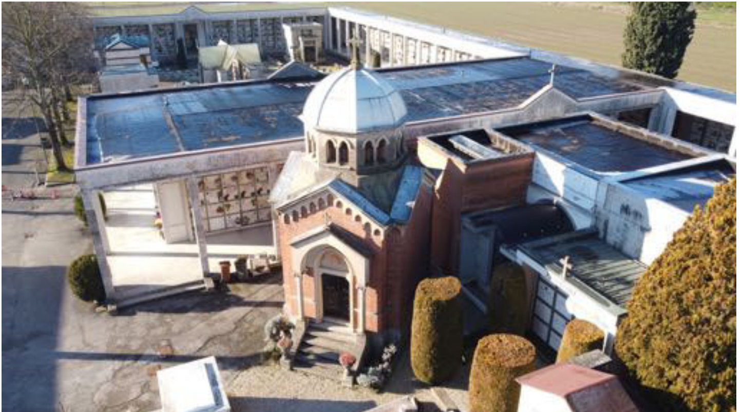
Vista aerea interna
