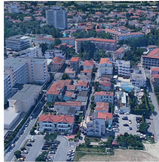
ISOLA DI CALORE - Centro urbano
