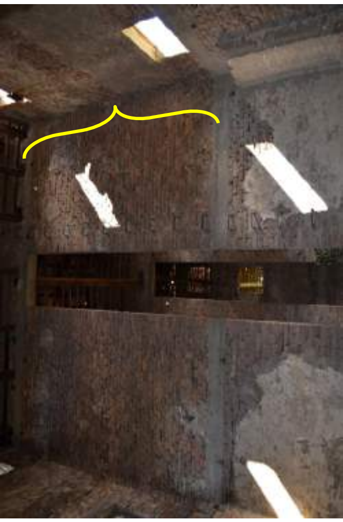
DETTAGLIO DELLA MURATURA INTERNA DELL'EDIFICIO E, CON INDIVIDUATA LA PORZIONE IN SOPRAELEVAZIONE
