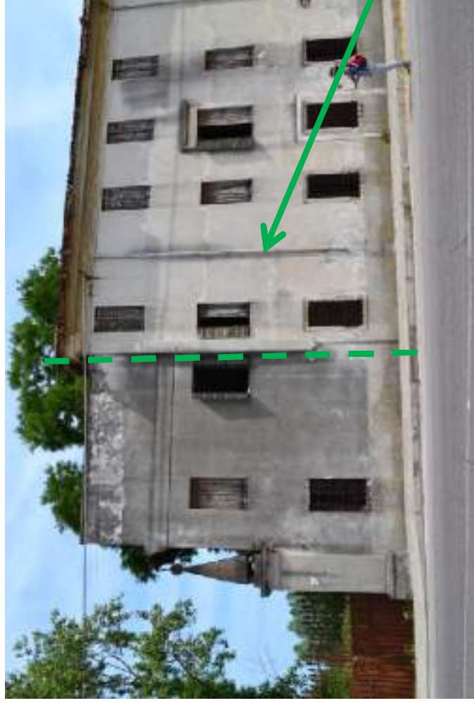
DETTAGLIO ESTERNO DELLA BARCHESSA C, ANGOLO INTERNO A NORD-OVEST, DA CUI SI EVINCE CHE IL BLOCCO OVEST PARALLELO ALLA STRADA ERA PIÙ ALTO (LA FINESTRA È STATA TAGLIATA DALLA SOPRAELEVAZIONE DEL BLOCCO EST)
