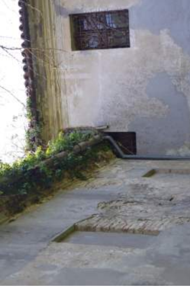
DETTAGLIO ESTERNO DELLA BARCHESSA C, ANGOLO INTERNO A NORD-OVEST, DA CUI SI EVINCE CHE IL BLOCCO OVEST PARALLELO ALLA STRADA ERA PIÙ ALTO (LA FINESTRA È STATA TAGLIATA DALLA SOPRAELEVAZIONE DEL BLOCCO EST)
