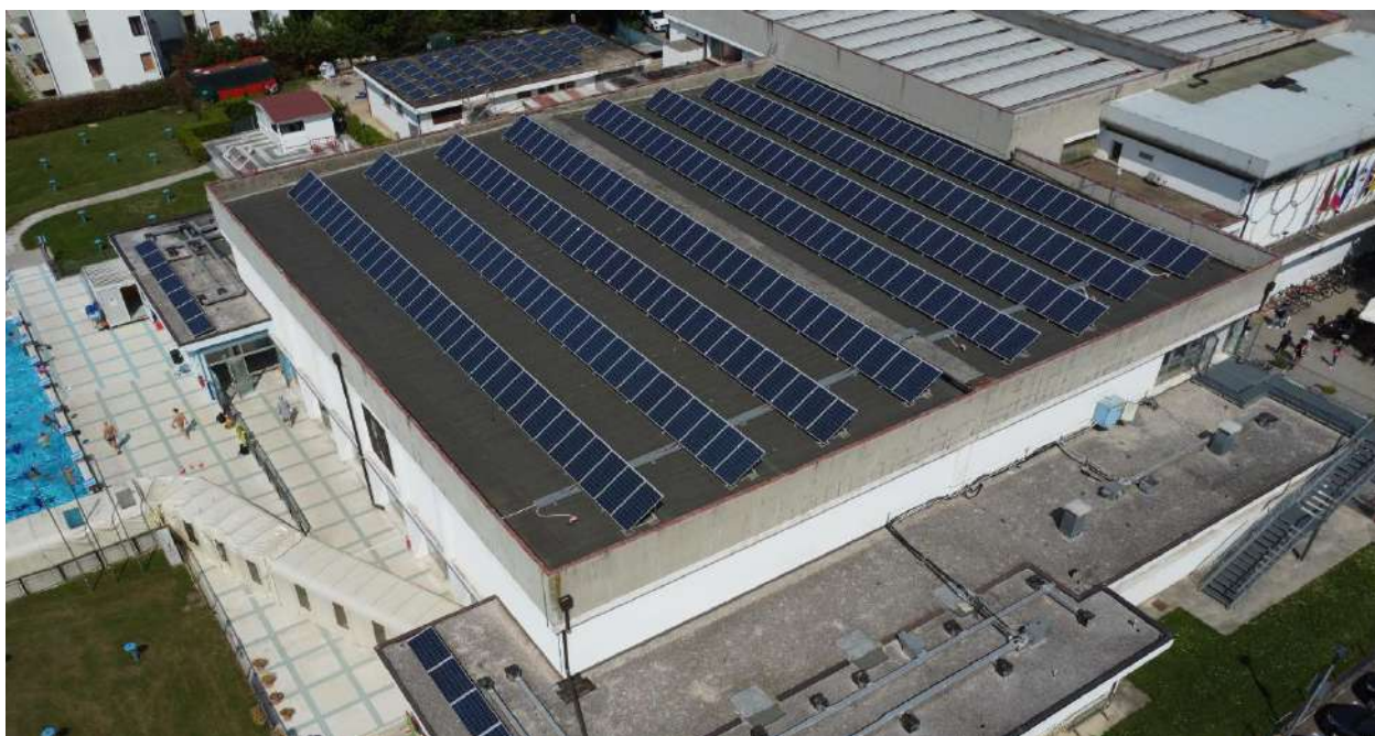
Campo fotovoltaico su copertura Piscina: stato attuale
