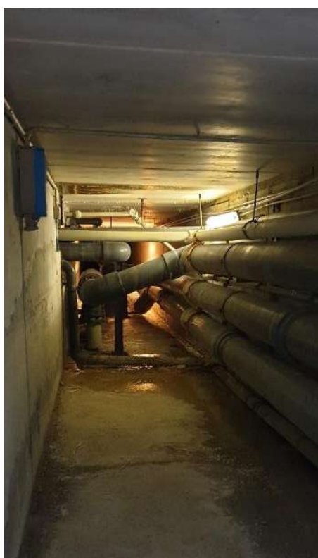
Cunicoli impianto piscina esterna
