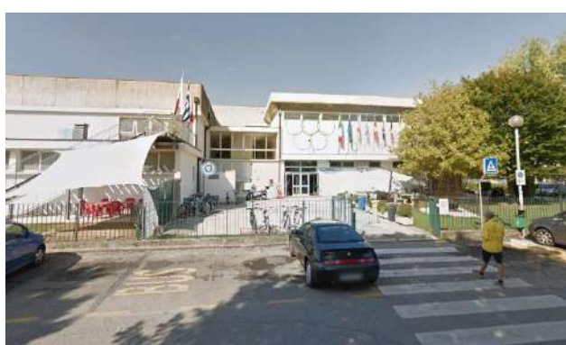
Vista da est accesso pedonale
