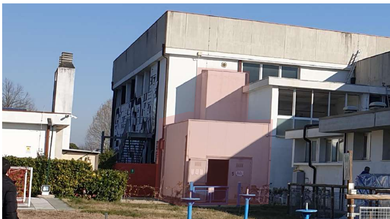
Lato ovest del complesso verso il corpo centrale termica. Il locale deposito piscina.(evidenziato in rosa)
