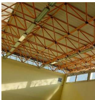
Veduta interna della copertura
