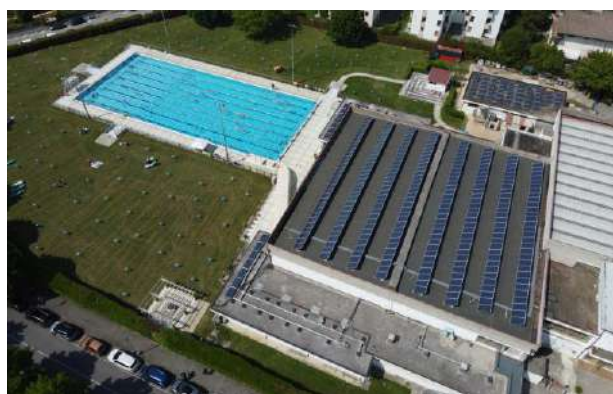
Vista dal drone – piscine
