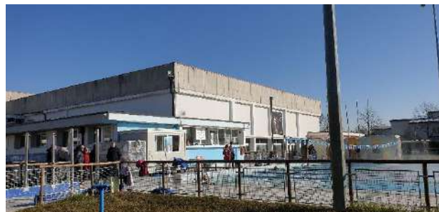
Veduta della palestra dalla piscina esterna
