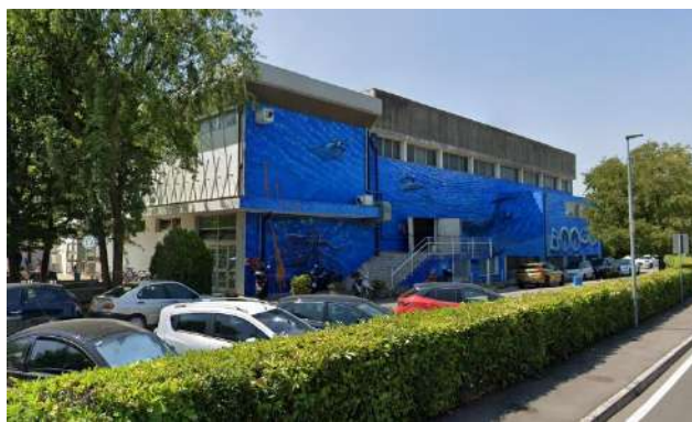
Vista da nord accesso carrabile
