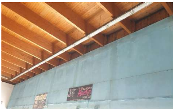
Condense sulle pareti e sulla trave di bordo
