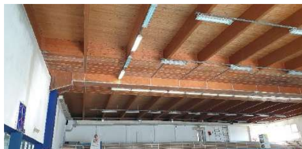
Veduta interna della struttura di copertura
