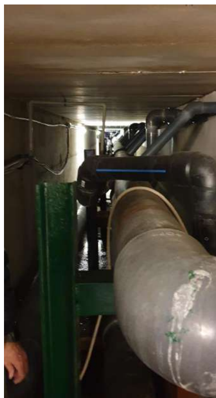
Cunicoli impianto piscina esterna
