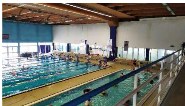
Veduta interna del vano vasca dalla gradonata
