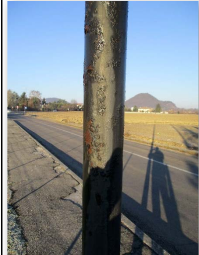
Via Pillon: Elevata corrosione dei sostegni
