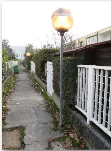
Via Sansovino: Apparecchi a Sfera equipaggiati con lampade di potenza eccessiva
