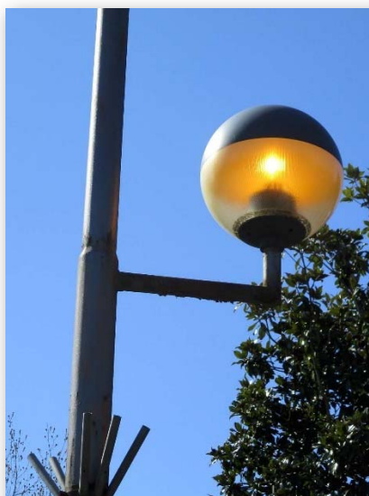
Via Sansovino: Apparecchi a Sfera equipaggiati con lampade di potenza eccessiva
