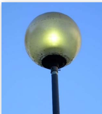
Via Busonera: Apparecchi a Sfera equipaggiati con lampade al mercurio
