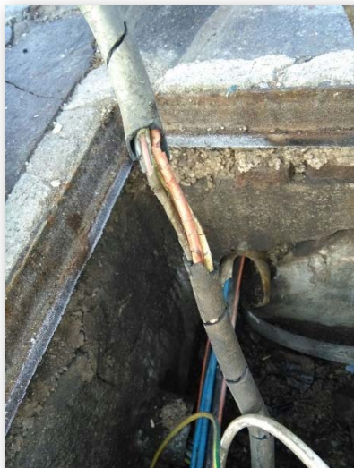
Via Gobetti: linea elettrica in dispersione
