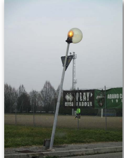
Via Carota: Punto luce incidentato
